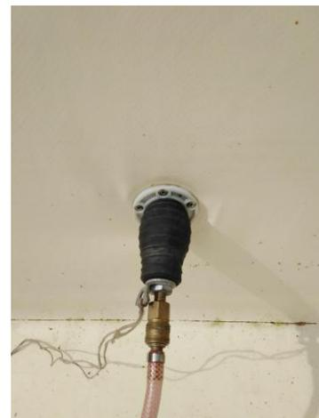
Absperrung der Düse zur Druckprobe
